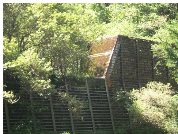
Fig. 7 小屋の沢砂防堰堤 1
