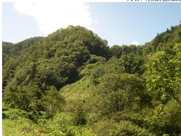
Fig. 9 山体崩落の跡
