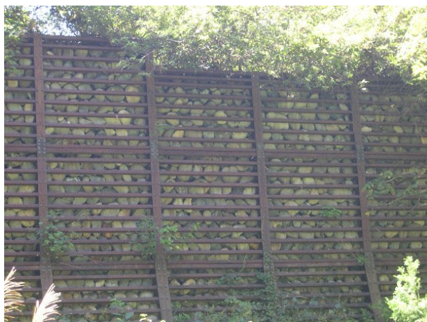
Fig. 8 小屋の沢砂防堰堤 2
