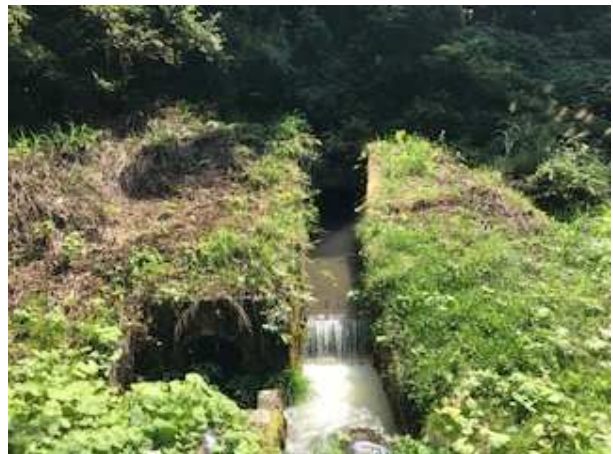
Fig. 5 奥が新堰 左手前は旧堰出口 写真手前で左（中川）、右（大志）に分流される
