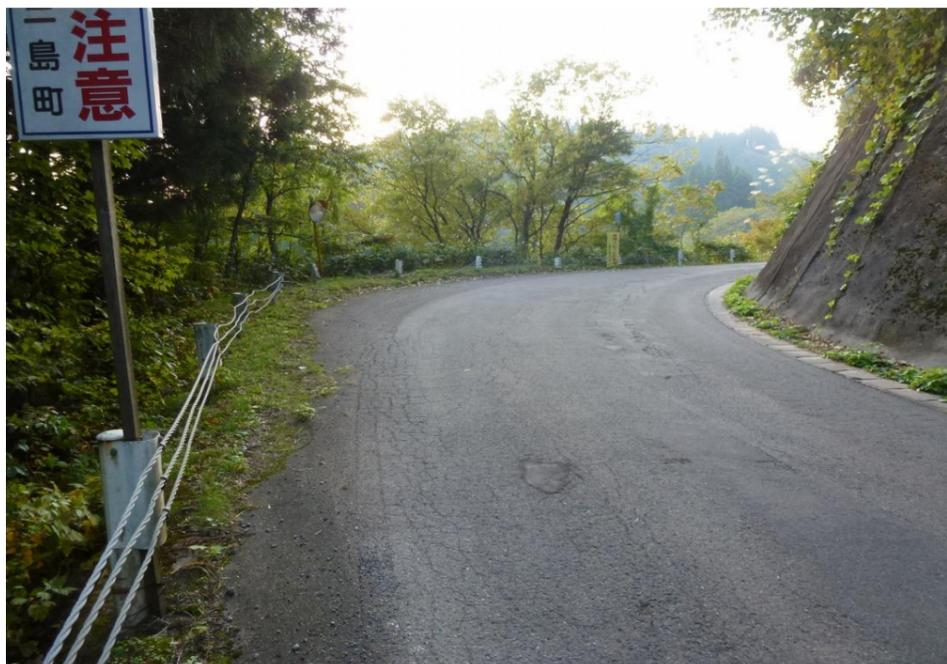
写真1 書面に小さく見えるカーブミラーの付近まで水圧管路を道路埋設し、左の斜面を発電所に向かって下ろす想定である。
